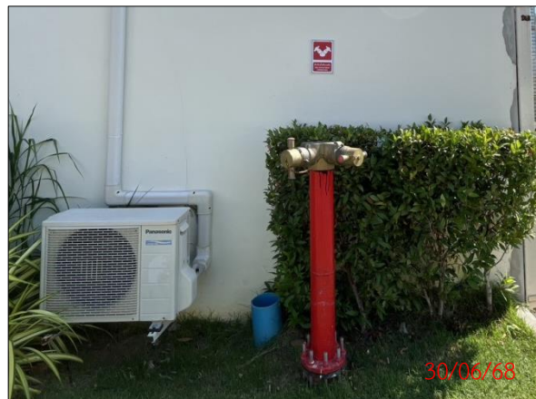
หัวรับน้ำดับเพลิง บริเวณอาคารสำนักงาน และห้องเครื่อง (อาคาร H)
